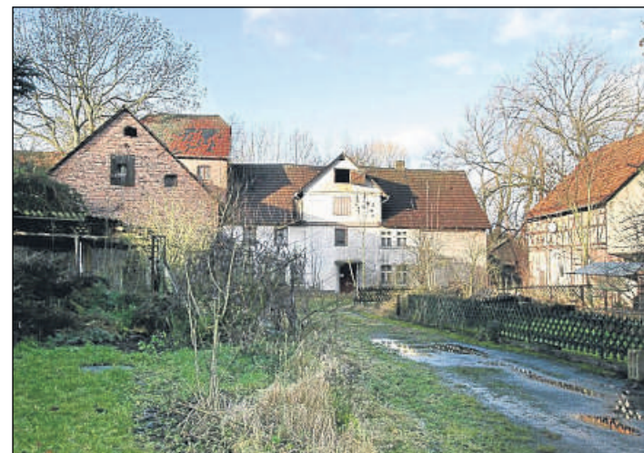
Vorher: So sah das Ensemble im Januar 2012 aus: Das Mühlengebäude (bleibt bestehen) ist links zu sehen, in der Mitte steht das weiß getünchte Wohnhaus, rechts die Scheune.
