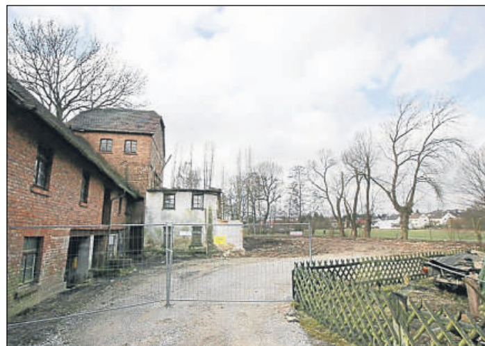
Nachher: Scheune und Wohnhaus sind zum Großteil verschwunden, der Blick auf den Ahnepark ist frei. Nur ein Teil des Wohntrakts stützt noch den Mühlturm.
