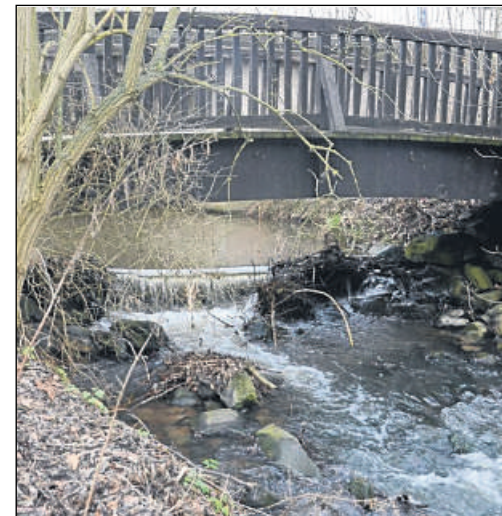
Hindernis für Fische: Dieser Absturz in der Ahna unter der Brücke wird zu einer rauen Rinne umgebaut.
