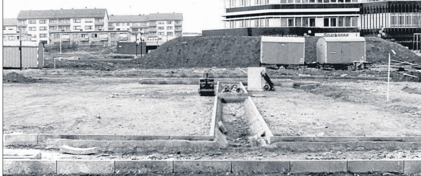
Der Dino: Das Vellmarer Rathaus (Fotos) war eines der ersten Gebäude, das in der neuen Stadtmitte in den 70er-Jahren gebaut wurde. Hier der noch unverstellte Blick von der Baustelle der Einkaufspassage auf das Verwaltungsgebäude.
