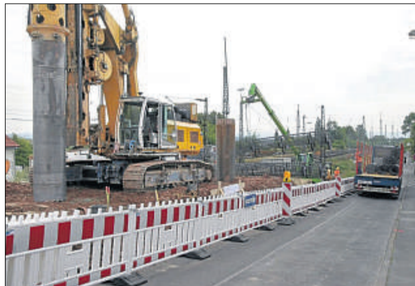
Bohrungen: Zehn Meter tiefe Löcher werden hier entlang der Rote-Breite-Straße am Bahnhof Obervellmar gebohrt. Diese werden dann mit Stahlbeton ausgegossen, um den Hang für die Lärmschutzwand zu sichern.
