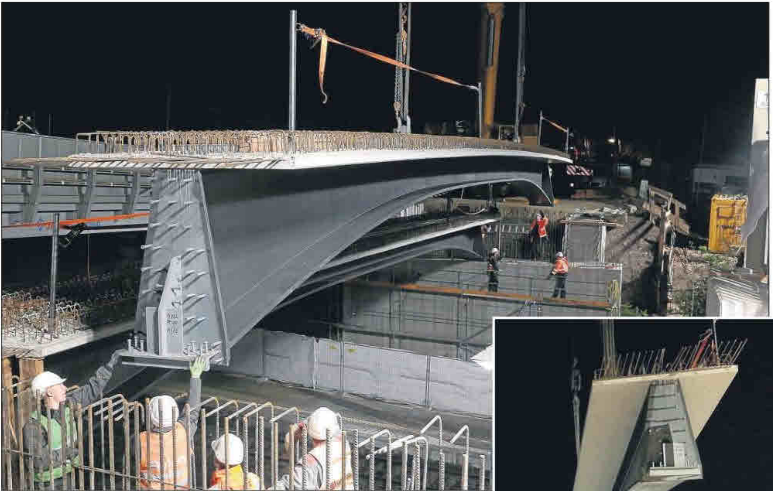
Millimeterarbeit: Ein 33 Meter langes Bauteil aus Stahl und Beton wird vorsichtig auf die beiden Widerlager gesenkt. Für die Bauarbeiter und Ingenieure erfordert diese Arbeit hohe Konzentration.
