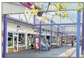
Veraltet: Die Einkaufspassage soll abgerissen werden.
