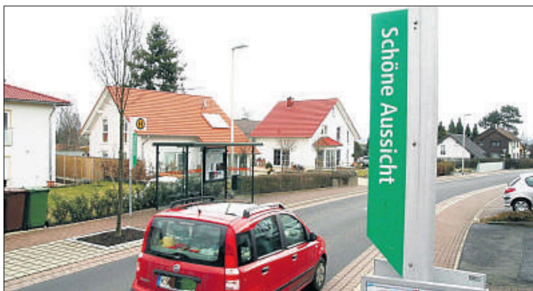
Saniert: Die Straße Schöne Aussicht in Obervellmar war die letzte, die von Grund auf erneuert wurde einschließlich der Haltestellen für den Bus. Auch die Anlieger mussten Gebühren zahlen. Foto: Schräer
