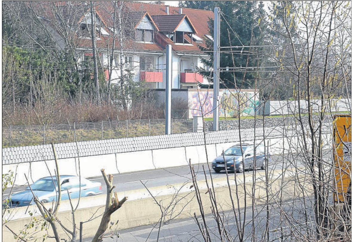
Häuser und Straße auf Tuchfühlung: Entlang der Bundesstraße 7/83 in Vellmar stehen viele Wohngebäude nur wenige Meter von der vierspurigen Straße entfernt. Auf ihr ist Tempo 100 erlaubt.
