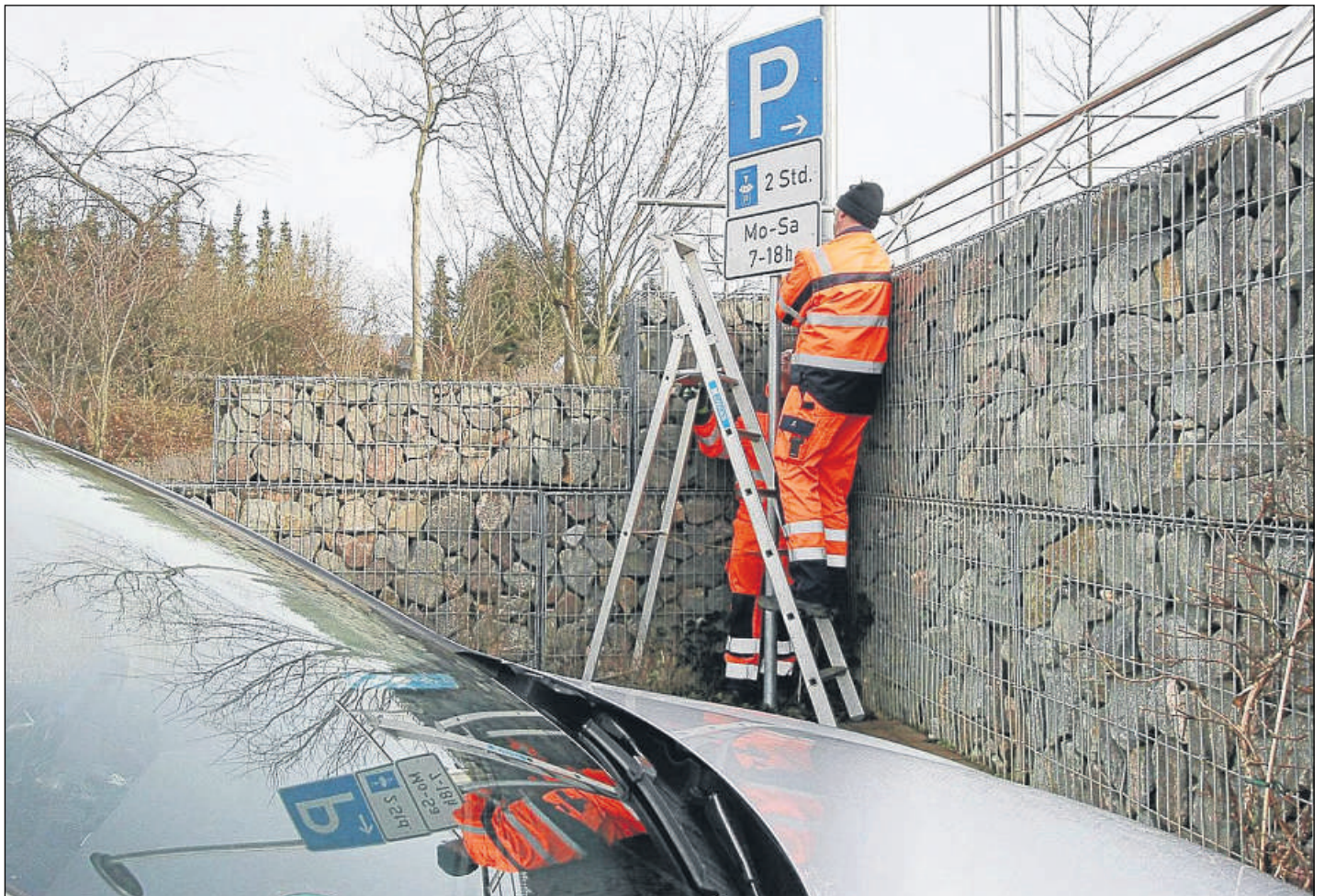
Letzte Arbeiten: Gestern brachten Mitarbeiter des Bauhofes die letzten Hinweistafeln dafür an, dass bei den Parkplätzen rund um das Parkhaus Parken nur noch zeitlich befristet mit Parkscheibe möglich ist.
