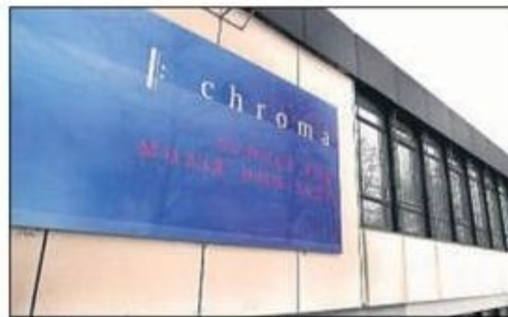
Modernisierung: Grundlegend erneuert werden soll die Musikschule Chroma.
