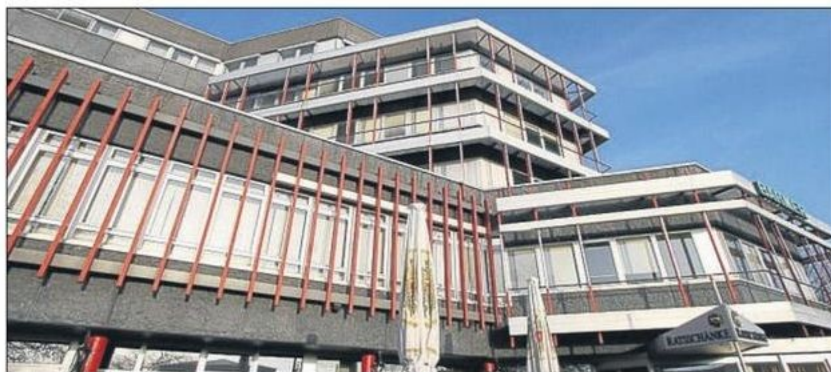
Sanierung Rathaus: Ende Januar soll eine Findungskommission ein Büro vorschlagen, dass den Planungsauftrag bekommen soll.
