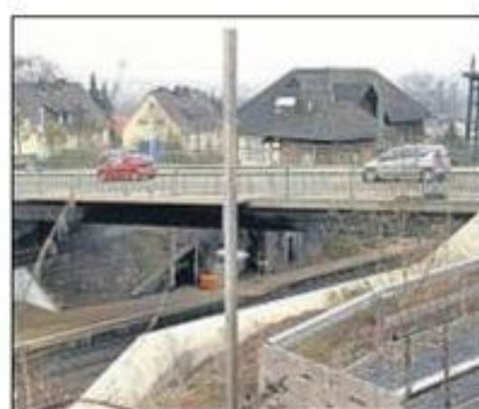
Neubau Brücke: Der marode Bau am Bahnhof kommt weg.
