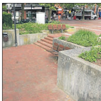
Modernisierung des Rathausplatzes mit Einkaufspassage,
