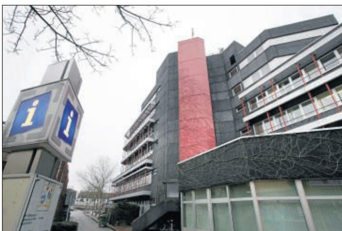
Rettungsweg: Bedingt durch die kaskadenartige Bauweise des Rathauses gibt es nur wenige Möglichkeiten, ein zweites Treppenhaus anzubauen.
