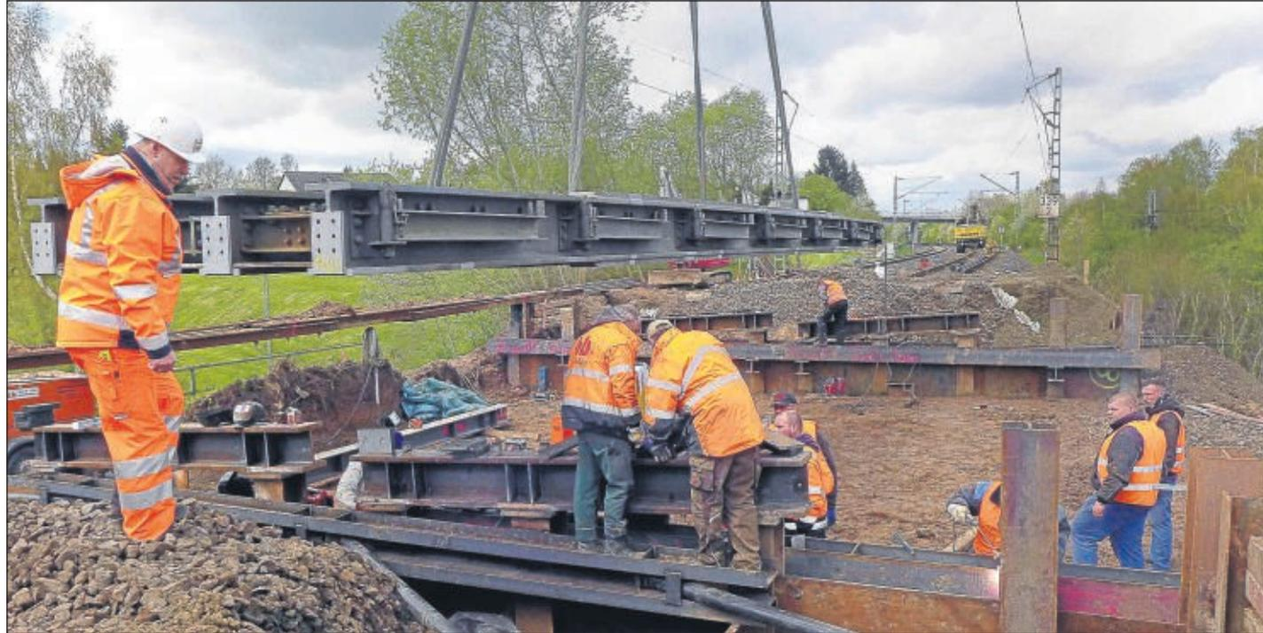
**Schweres Gewicht:** Mit einem 400-Tonnen-Kran wurden die beiden Stahlteile der Hilfsbrücke präzise auf den bereits montierten Teilen abgesetzt. Trotz widriger Wetterverhältnisse waren die Bauarbeiter ihrem Zeitplan voraus.
