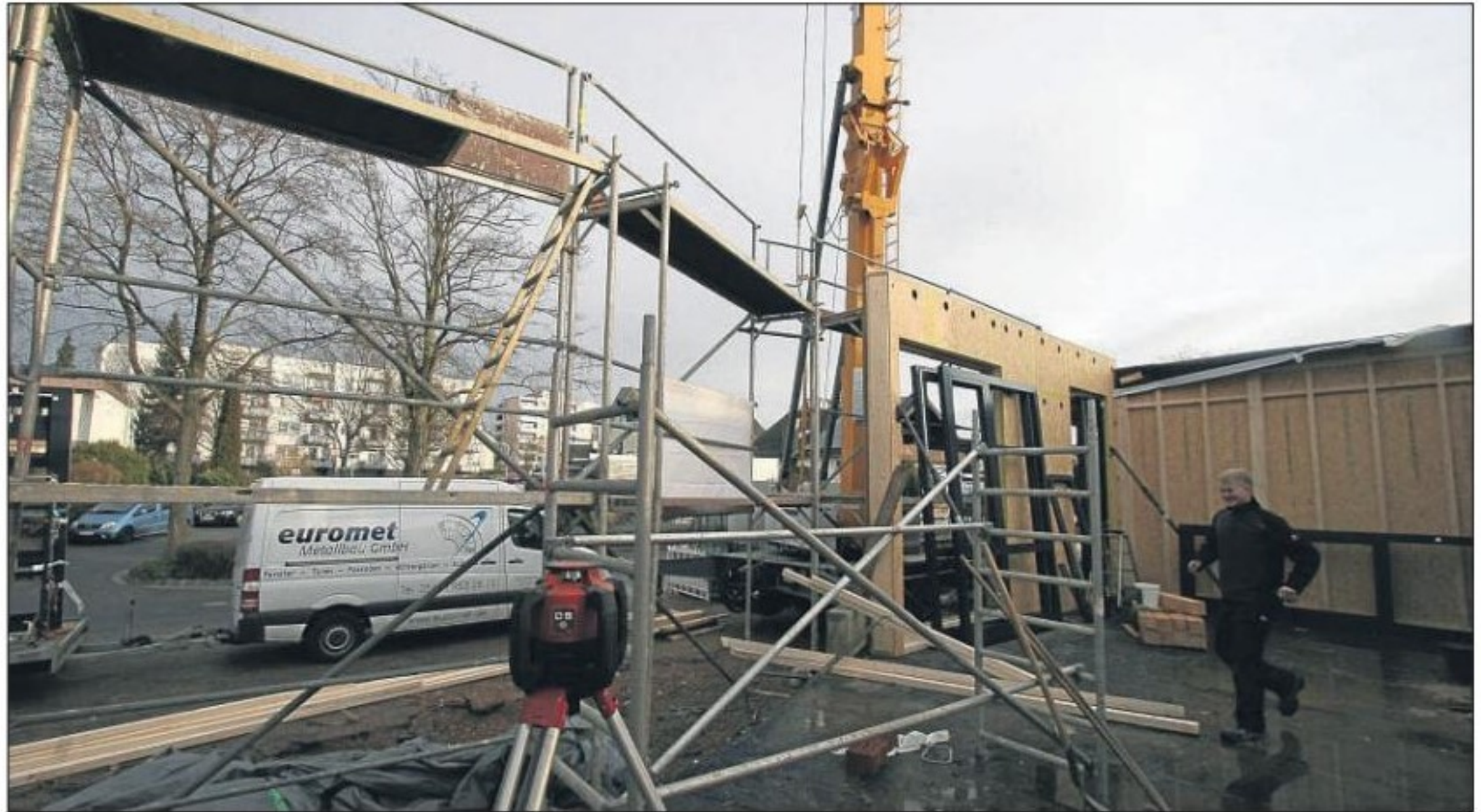
Ausblicke: Große Fensterfronten sollen für einen lichtdurchfluteten Eindruck sorgen. Der Blick geht hier aus dem zukünftigen Raum für das Ensemble-Spiel auf die Adalbert-Stifter-Straße.
