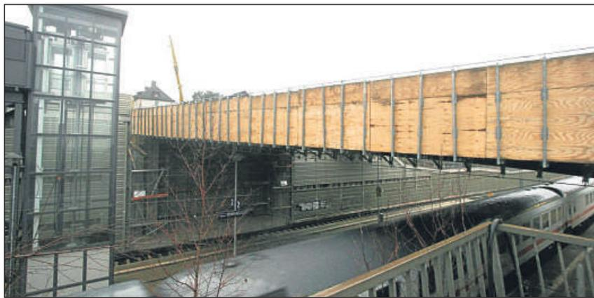
**Holzverschaltungen:** Diese werden mit Beton ausgegossen, an dem später die Geländer und Leitplanken angebracht werden. Links im Bild der neue Fahrstuhl zu Bahnsteig und den Gleisen, auf denen gerade ein IC vorbeirauscht.
