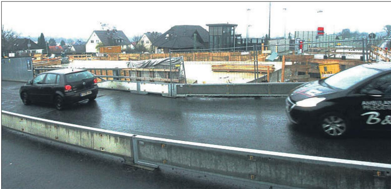
Die neue Brücke: Noch fließt der Verkehr über die Behelfsbrücke im Vordergrund. Dahinter erkennt man aber schon den Neubau mit einem Teil des noch nicht fertigen Straßenbelags.
