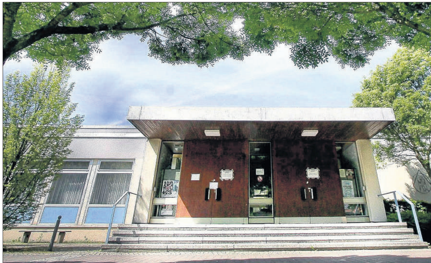
Seit vier Jahren geschlossen: Ein Gutachter fand im Jahr 2011 Asbest im Bürgerhaus in Obervellmar. Ein zweiter Gutachter kam zu einem anderen Ergebnis. Bislang gibt es in dem Konflikt keine Lösung.
